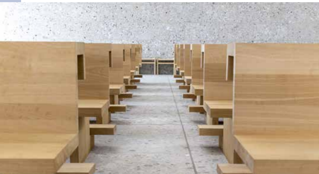
Damit die neuwertige Optik des Natursteinbodens erhalten bleibt, wurde er gegen fett- und wasserbasierte Verschmutzungen geschützt und kann leicht gereinigt werden werden
