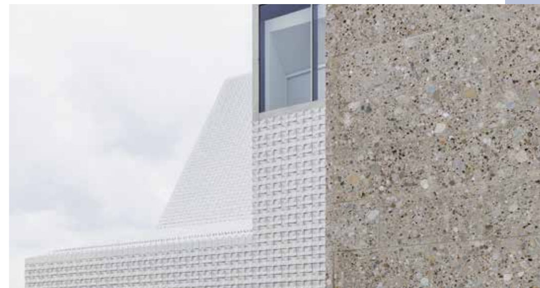
Tausende Keramikkacheln verzieren die ungewöhnliche Dachkonstruktion. Gefertigt wurden sie von der m&r Manufaktur GmbH und für einen unregelmäßigen Effekt von Hand glasiert
