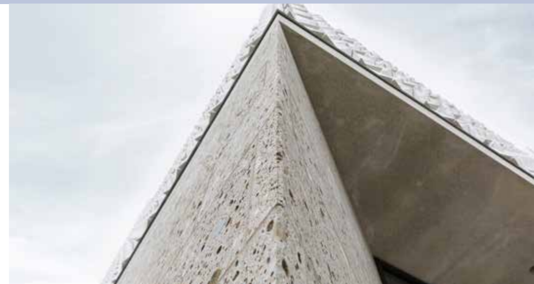
Fassade aus Nagelfluh: Große Poren und eine unterschiedliche Saugfähigkeit würden das Konglomeratgestein im ungeschützten Zustand anfällig für Schmutzrückstände machen
